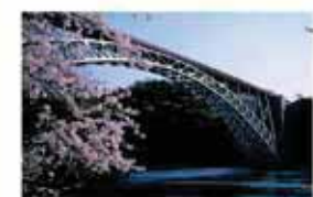
④ 西海橋 全長300メートルの西海橋の真下を 流れる大村湾の潮の僅かな出入口 となる伊ノ浦瀬戸、日本三大急瀬と いわれる
