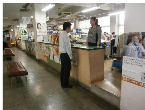
↑ 執務室の状況(廊下との段差)
