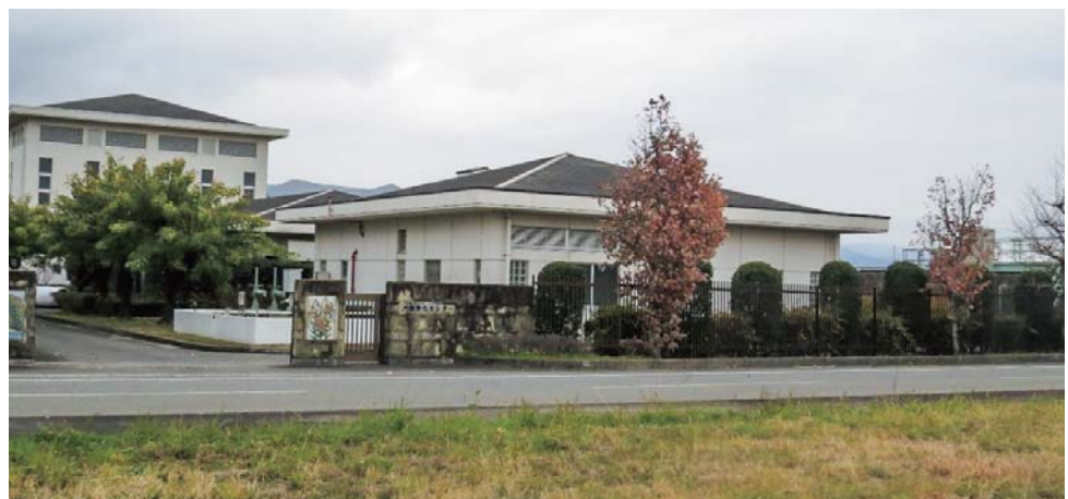
下水しより場（川棚浄化センター）
