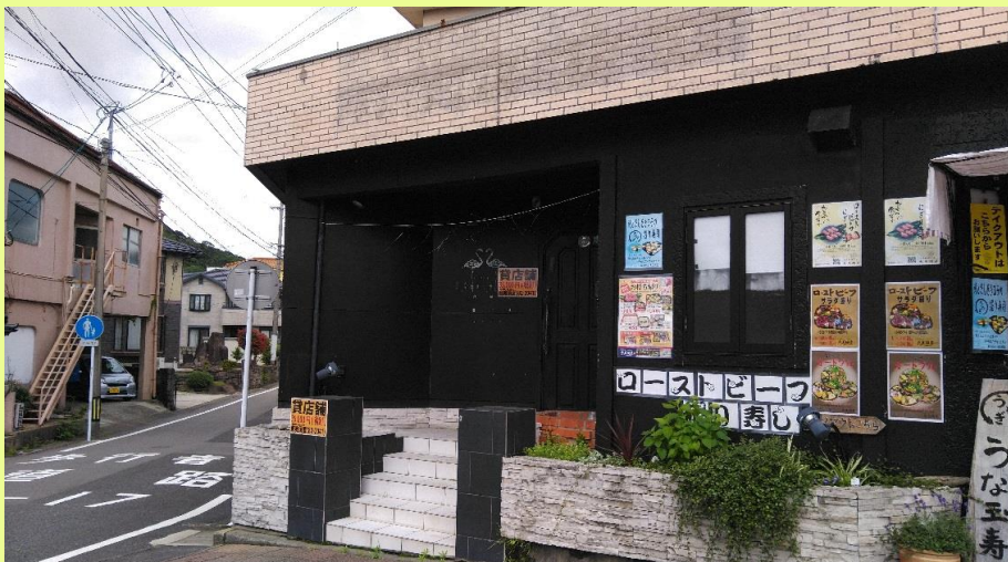
◀ 空き店舗外観
