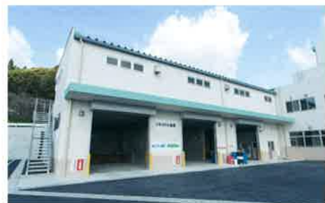
1 リサイクル倉庫
