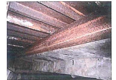
K0121-01_開1号橋 (下流側) (平島平石線)
