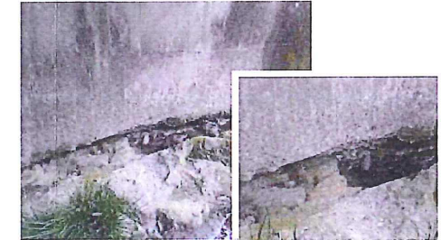
K0025-00_小山橋 (岩屋線)
