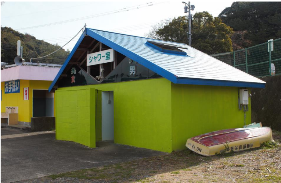
④シャワー棟
