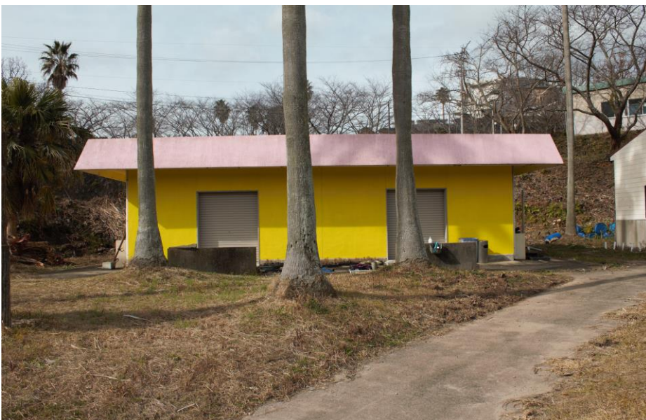
⑨ 旧トイレ・シャワー棟 ※現在は倉庫
