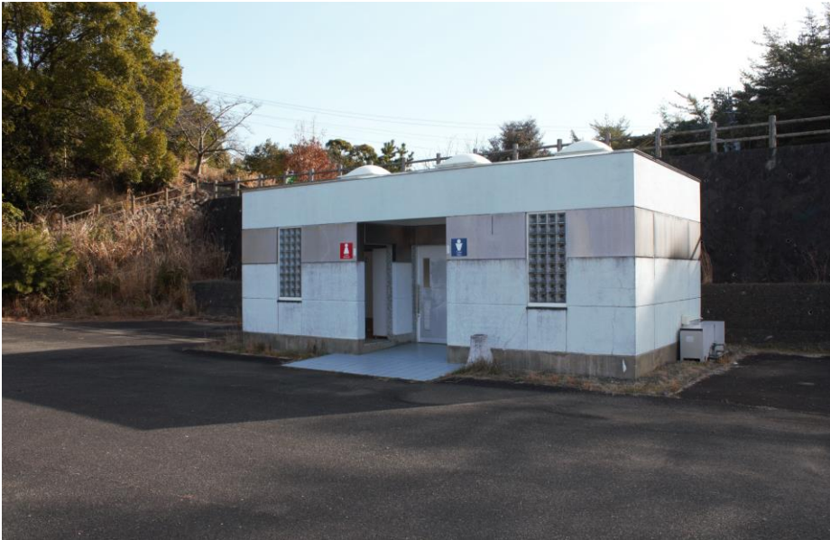
⑩トイレ棟③ (旧0-ラケット場内)
