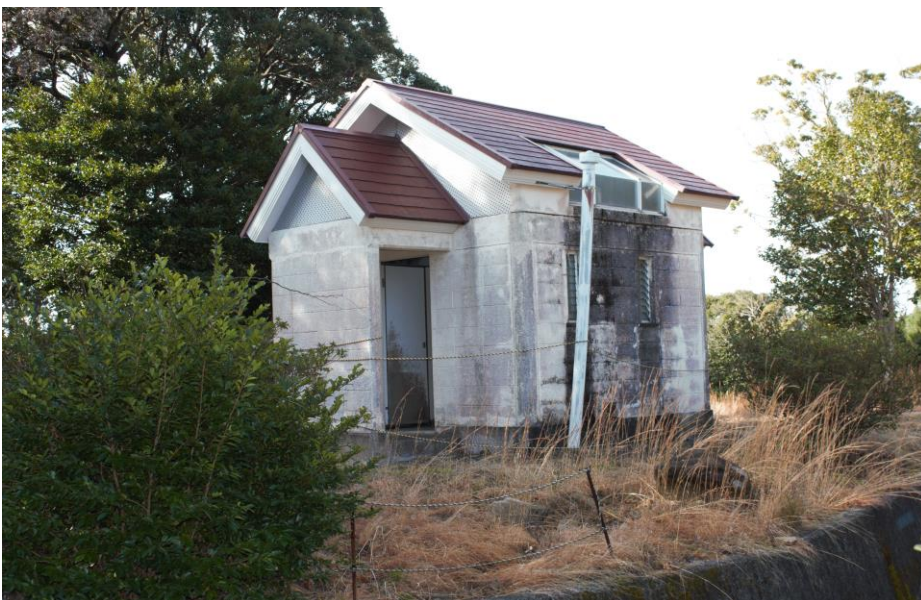
⑨トイレ棟② (ゴーカート場内) ※現在、未使用
