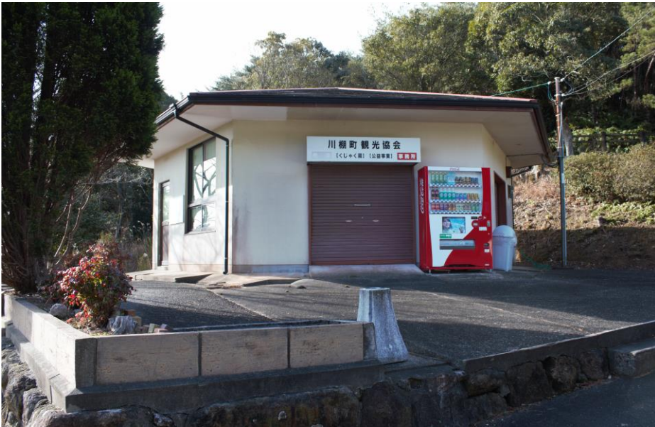
⑤かぜの広場管理棟 ※現在、未使用
