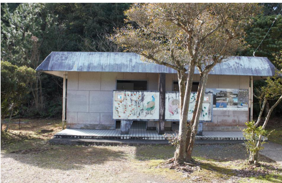
⑮トイレ棟④
