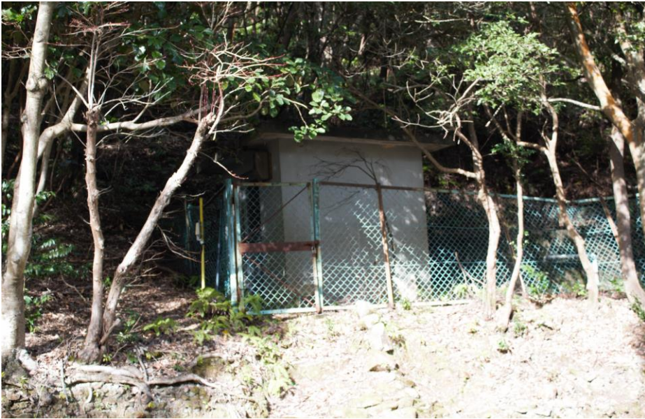
③水道ポンプ室②
