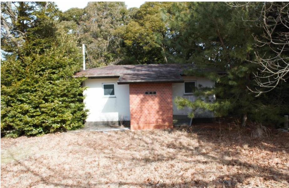
③トイレ棟⑥ (のんぽか山)
