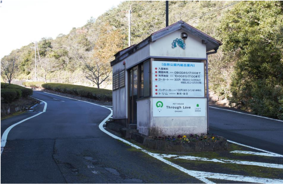
①入場管理棟 （くじゃく園入口） ※現在、未使用
