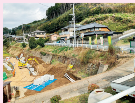
工事中の現地（12月下旬）
